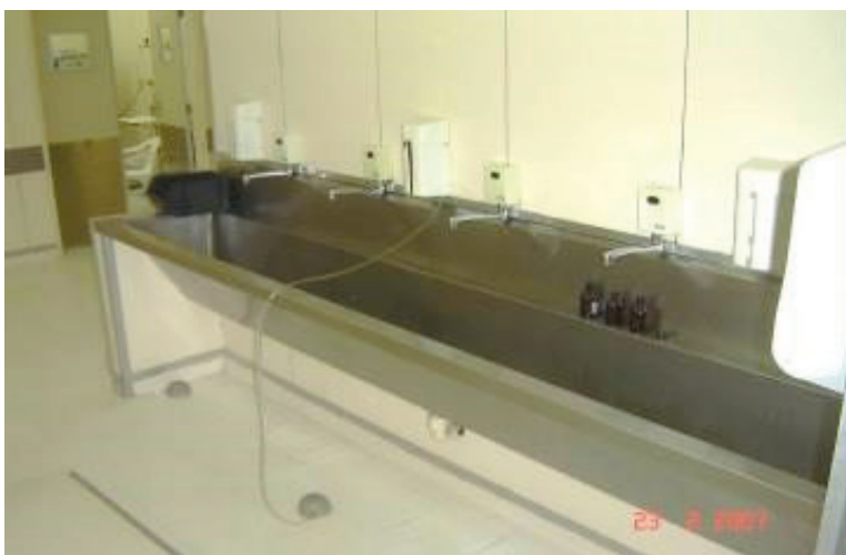
FIGURA 1– Lavabo do Centro cirúrgico (HUOL-UFRN).
