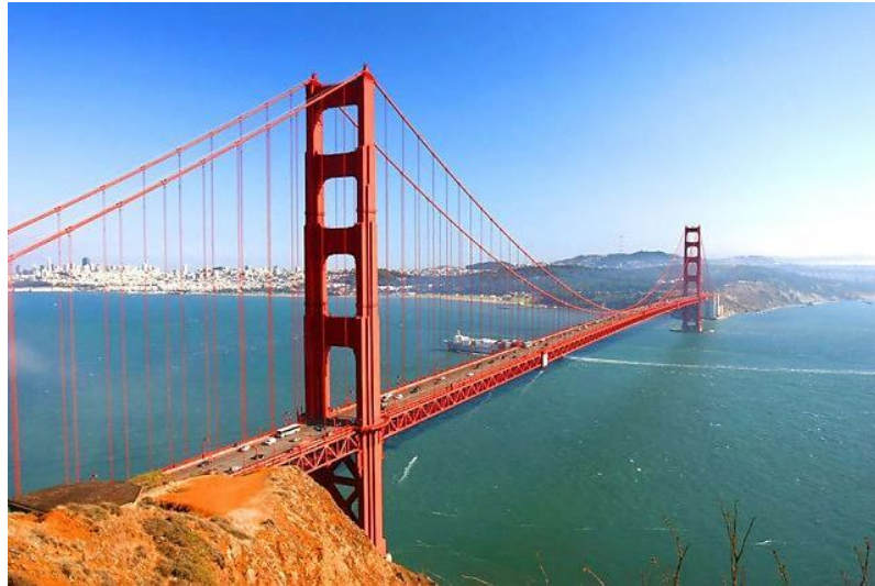
Figura 1 – Ponte Golden Gate
