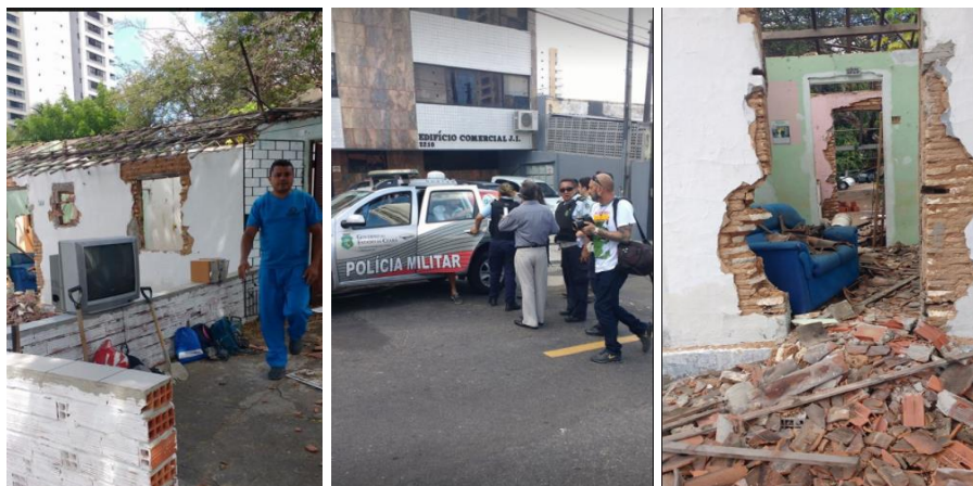
Figura 07. Demolição das casas no dia 27 de outubro de 2016.
