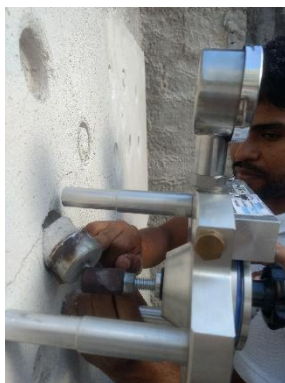
Figura 6: Ensaio de Arrancamento.
