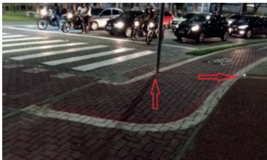
Foto 01: Registro dos autores.
