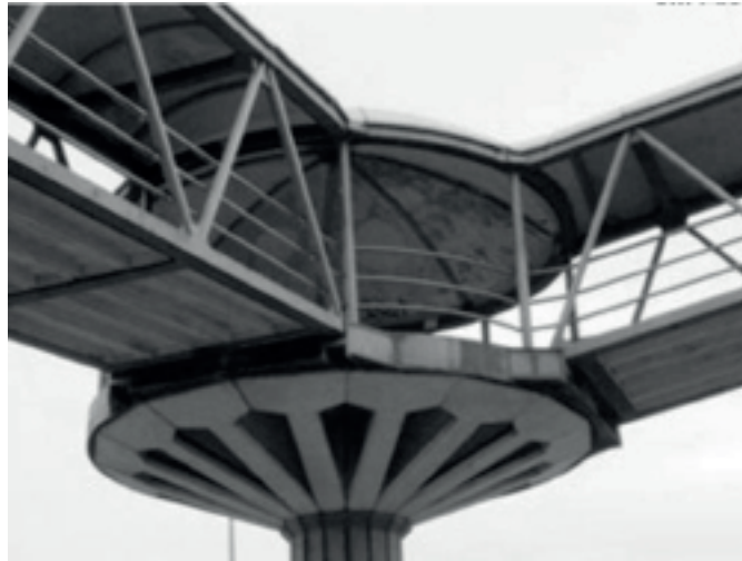
Figura 4: Rótula da Passarela CTRS
