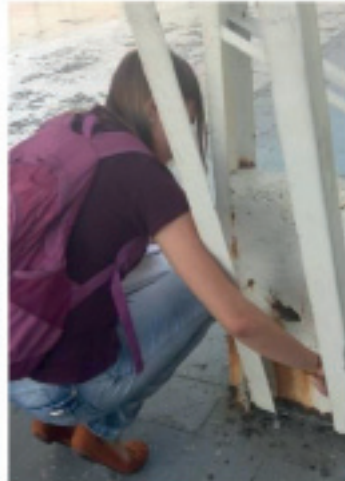
Figura 2 - Vistoria nas juntas
