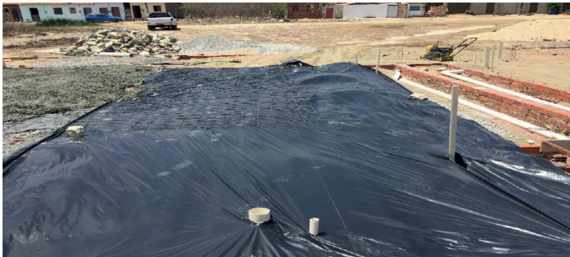
Figura 5 – Execução da fundação
