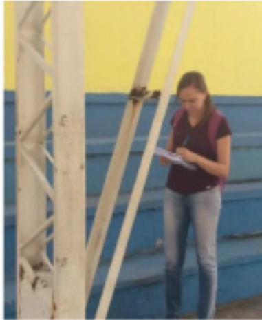
Figura 1 - Vistoria nas juntas
