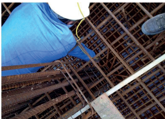
Figura 3 - Inserção do termopar no centro do bloco (Autores, 2016)
