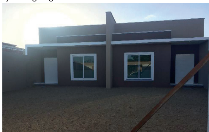
Figura 4 – Execução da garagem
