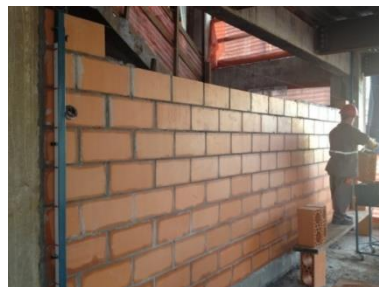
Figura 6 - Elevação da alvenaria com execução de rejuntes.
