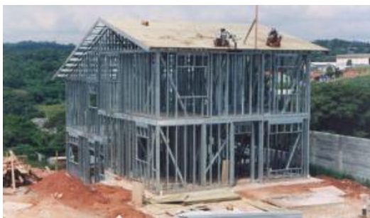
Figura 1 - representação da técnica construtiva Steel Frame
