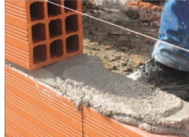
Figura 7 - Elevação da alvenaria com verificação do nível.
