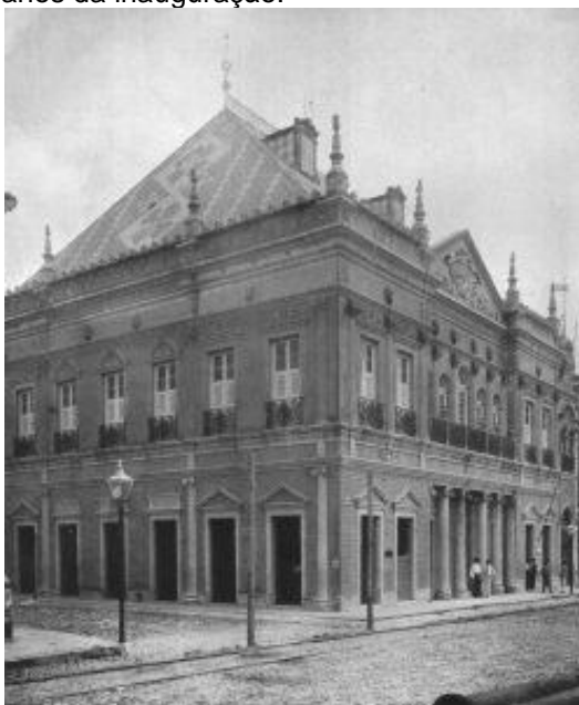
Figura 3 - Edificação após 2 anos da inauguração.
