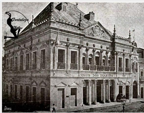
Figura 4 - Telhado íngreme de ardósia.
