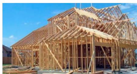
Figura 4 - Representação do sistema construtivo Wood Frame
